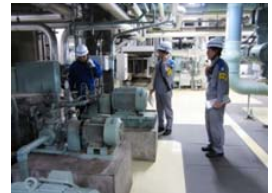
現場作業(OJT)
